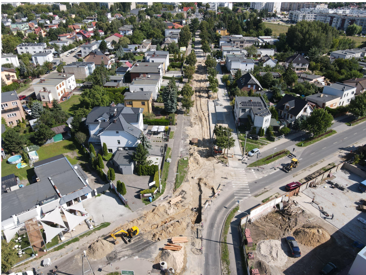
Zdjęcie nr 4. Skrzyżowanie ulic Żabikowskiej, Wschodniej i Wojska Polskiego w trakcie prac remontowych.
