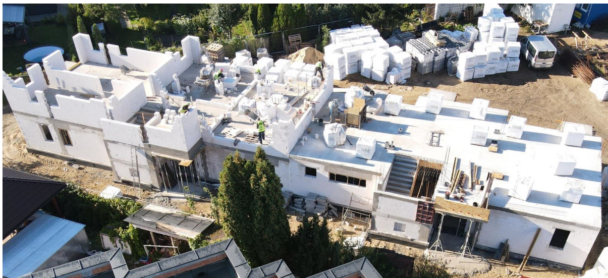
Zdjęcie nr 5. Budynek komunalny przy ul. Łącznej 4 w trakcie budowy.
