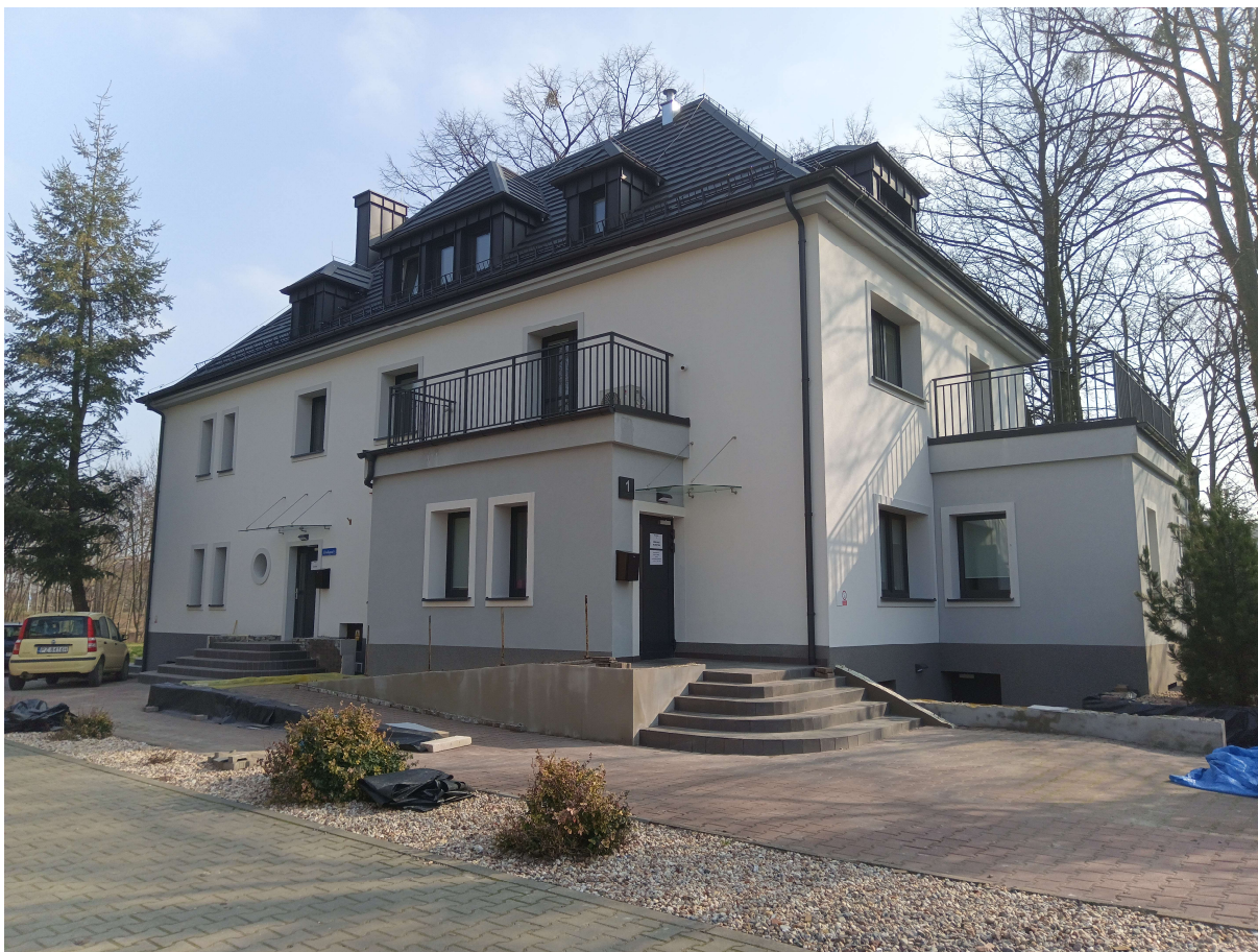
Zdjęcie nr 7. Budynek Miejskiego Ośrodka Pomocy Społecznej przy ul. Źródlanej w Luboniu po termomodernizacji.
