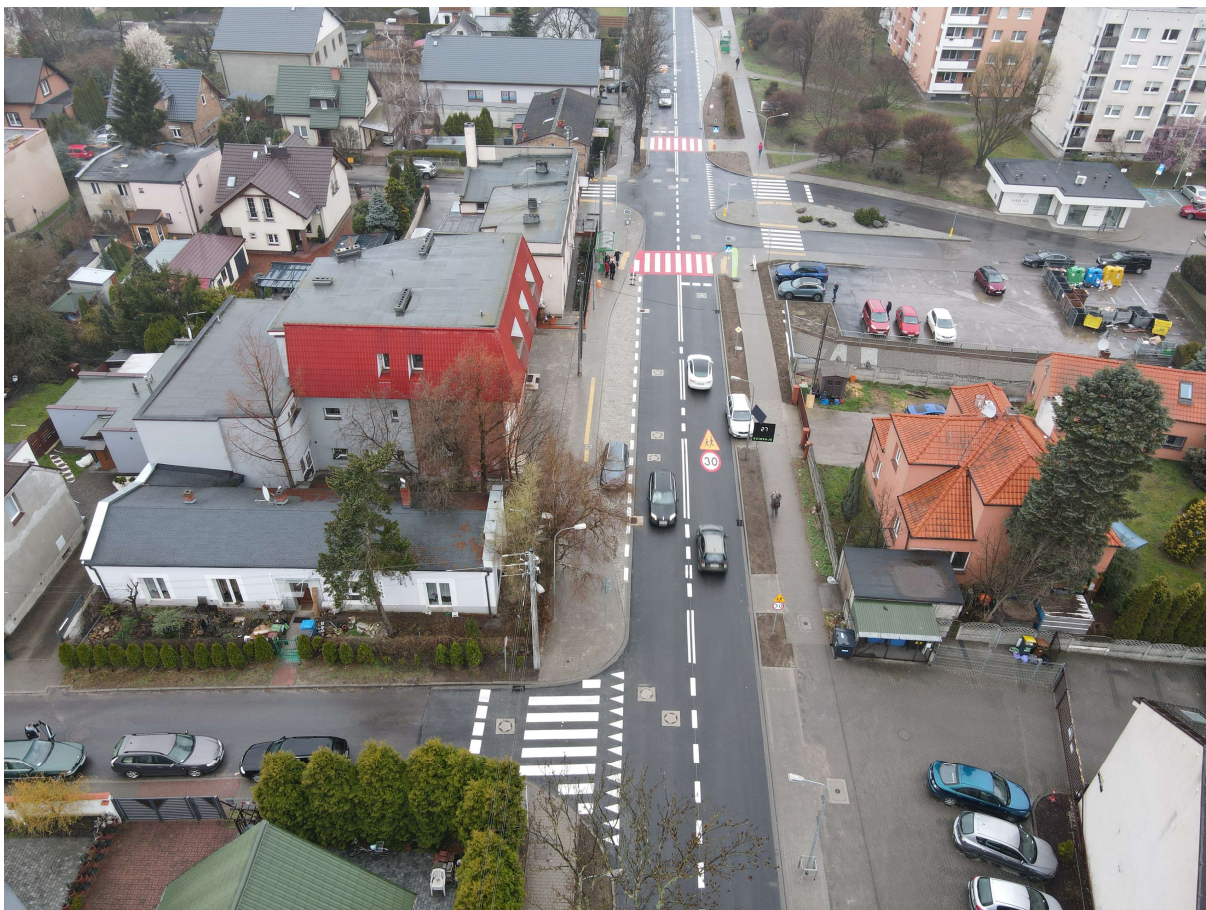
Zdjęcie nr 2. Ulica Kościuszki po zakończeniu remontu.
