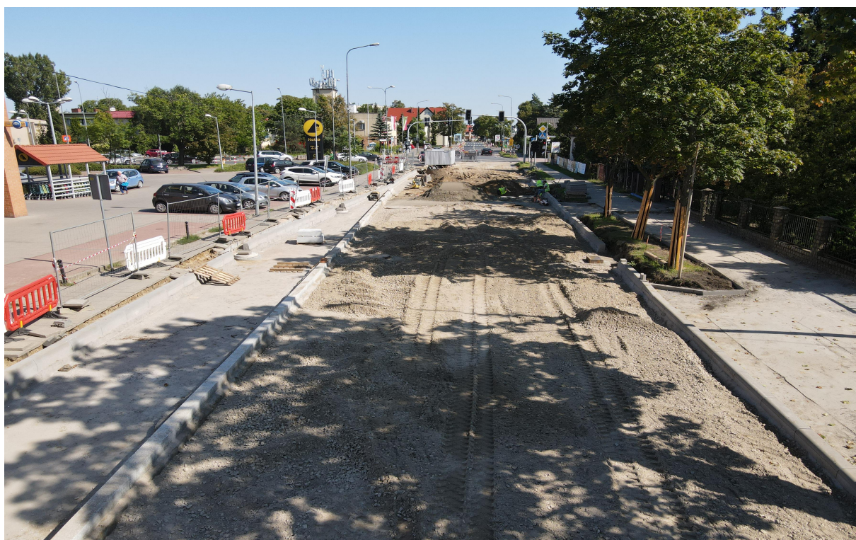
Zdjęcie nr 3. Ulica Żabikowska w trakcie prac remontowych.
