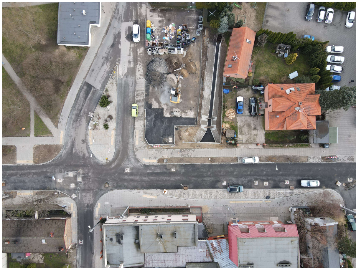
Zdjęcie nr 1. Skrzyżowanie ulic Kościuszki, Sikorskiego i Sienkiewicza w trakcie przebudowy ul. Kościuszki.
